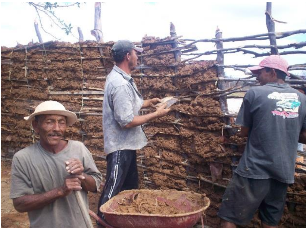
Reconstrução das casas
