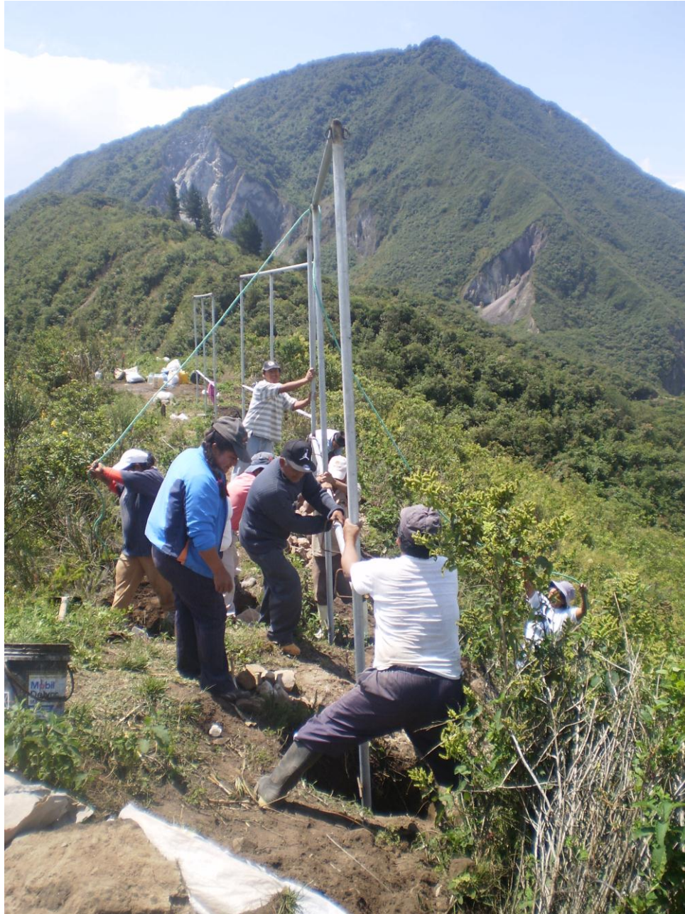
Instalación de mallas capta nieblas en Huacamullo
