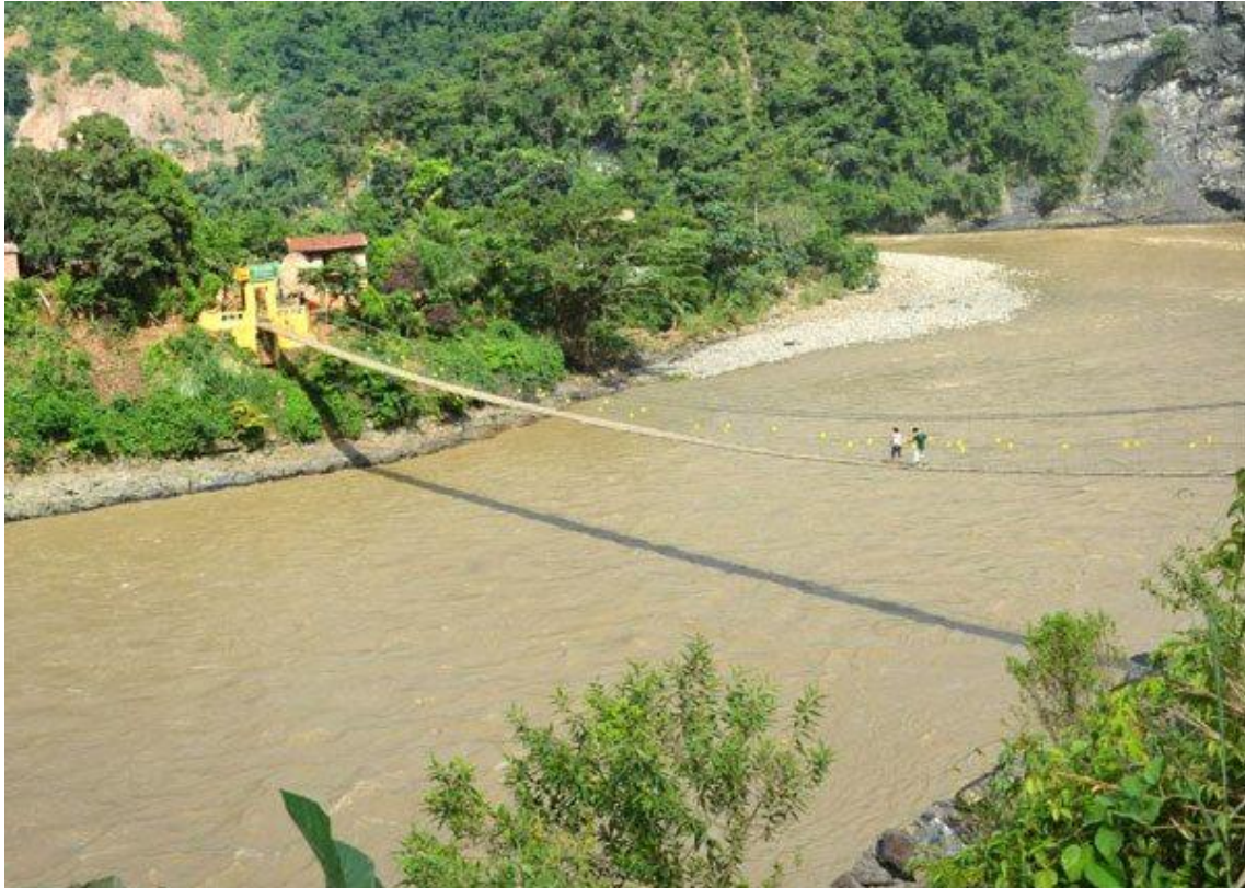
Ilustración 6: Puente colgante de acceso a la comunidad. Sobre el río Coroico
