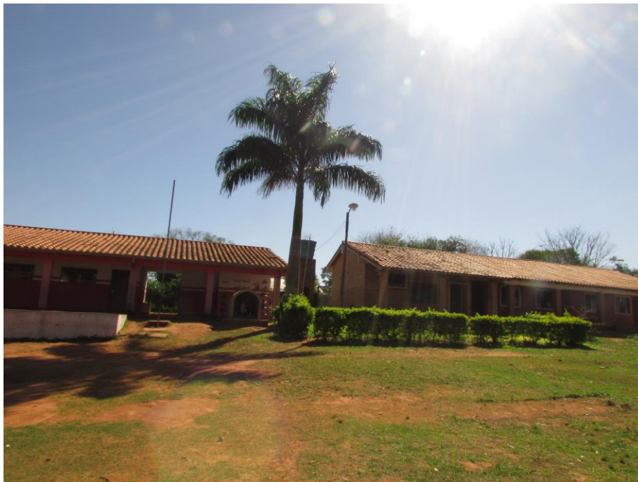
Una de las escuelas del Asentamiento
