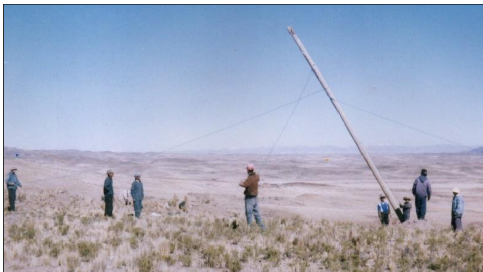
Trabajos para que llegue la electricidad a la comunidad Phina Sallathiji (2004)
