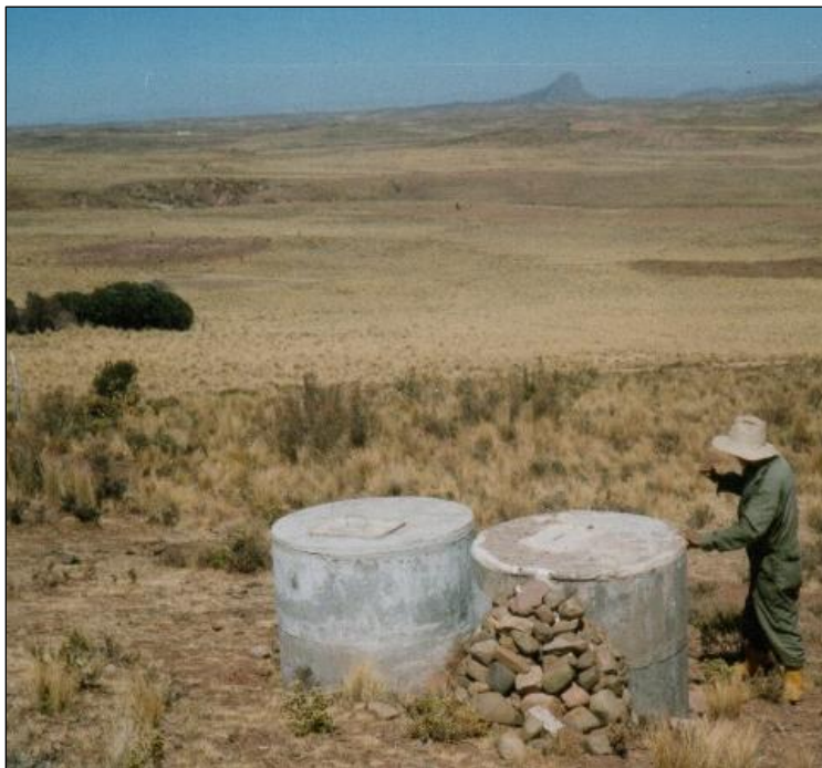
Tanque construido en una de las vertientes destinado para el consumo de la familia, el agua es transportado en cañería hasta la casa para la cocina, ducha y baño.
