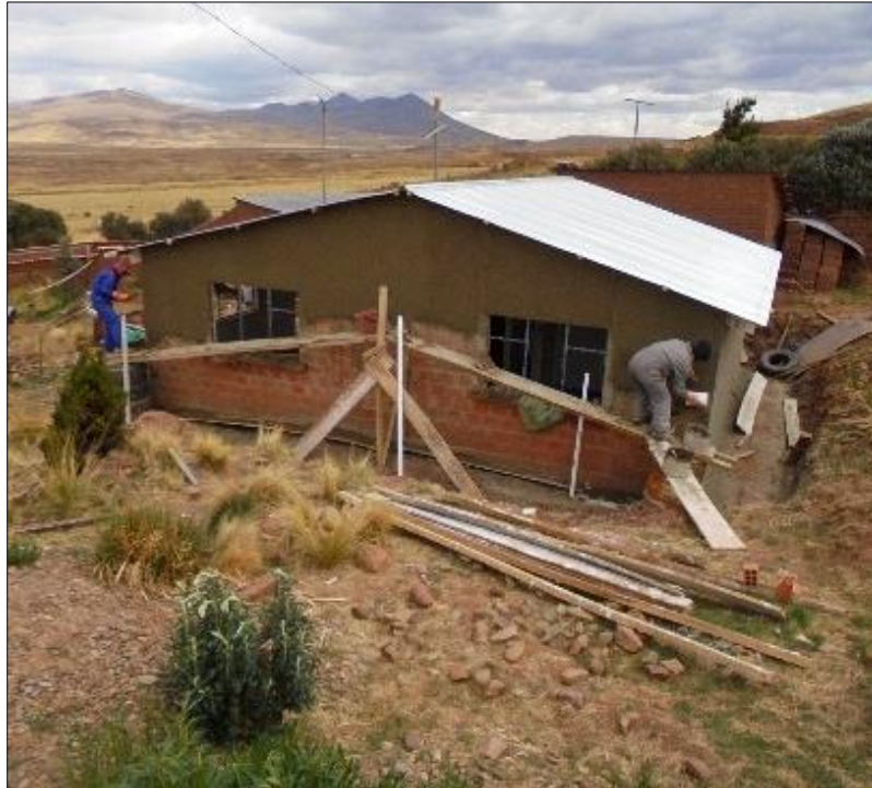
Ampliación de la vivienda
