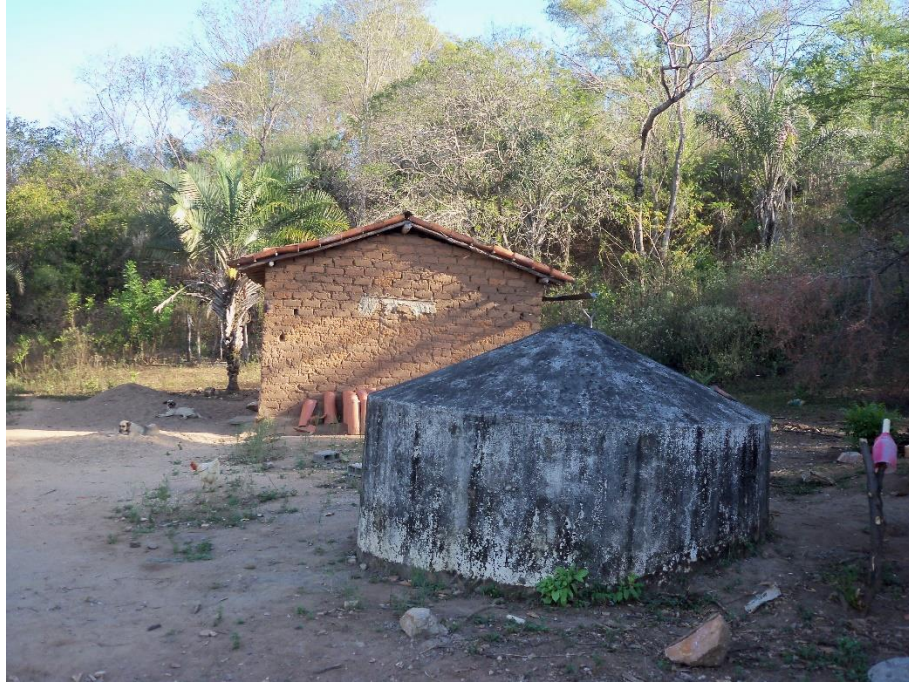
Política pública: cisterna de captação de agua da chuva
