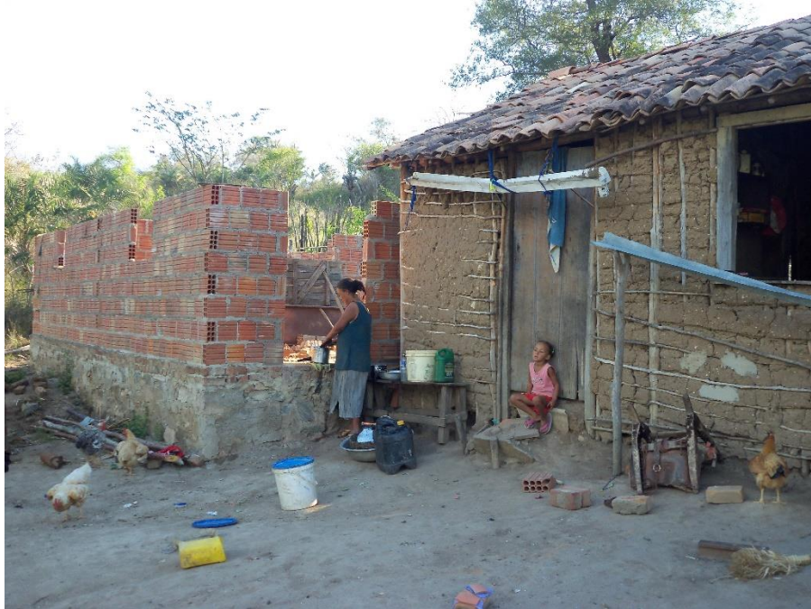
Casa sendo construída do lado do barraco
