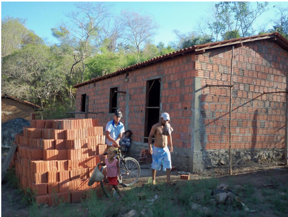
Construção das residências
