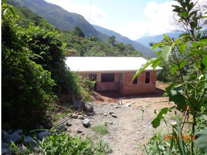
Nueva sede sindical en construcción. Esfuerzo de todas y todos los afiliados.
