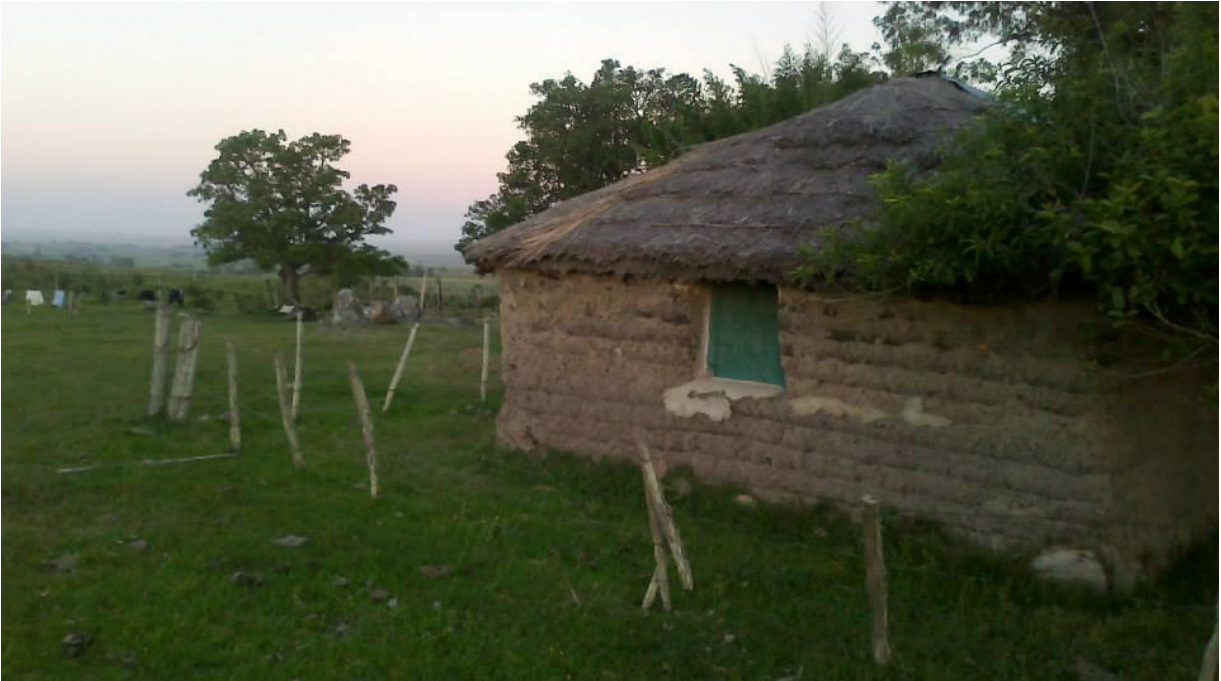
3.- Rancho típico en barro y paja. Las viviendas rurales se construyeron históricamente con materiales de la zona, lo que evidencia en el poblador, el arraigo y el saber construir su propia casa.
