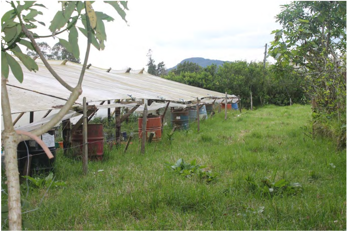
Aprovechamiento de aguas lluvias para el sistema de riego El CEBOYA 2019
