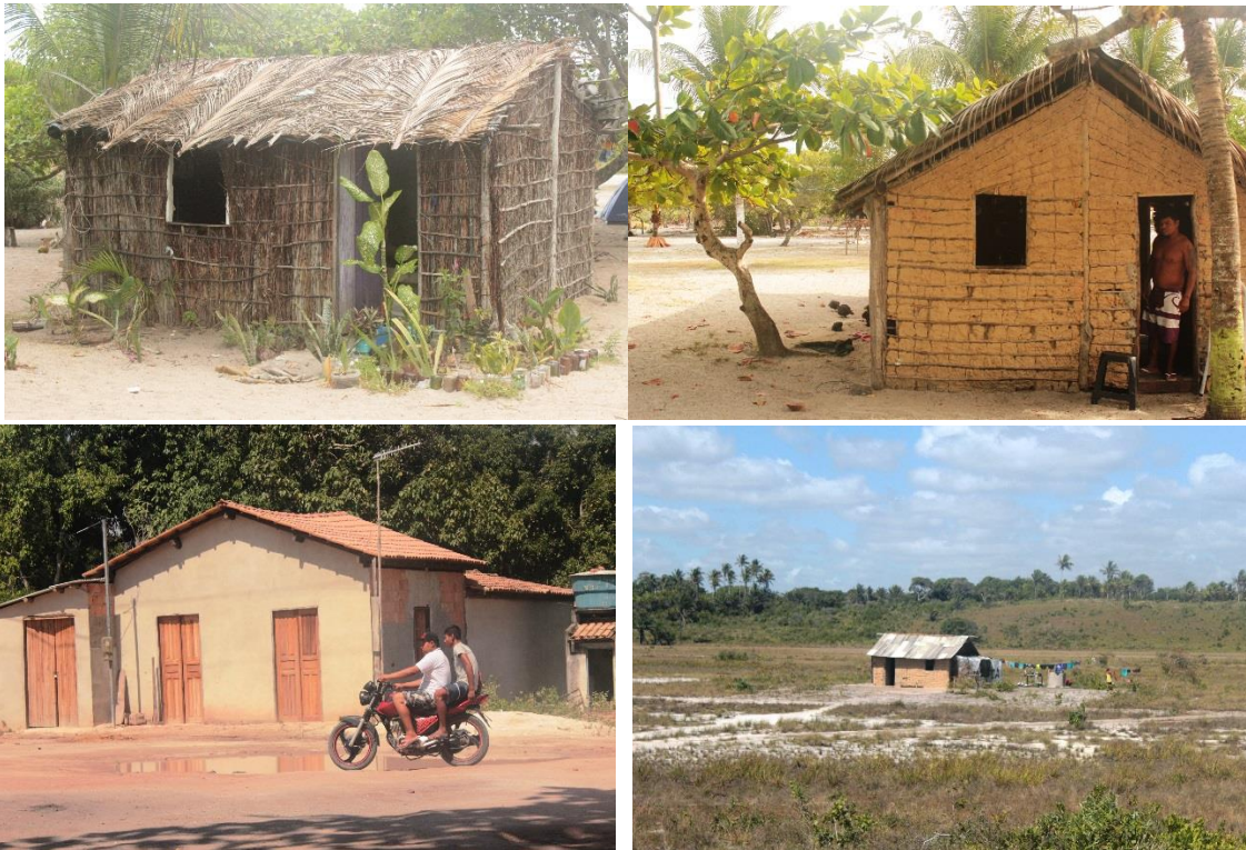
Casas de palha, pau-a-pique, alvenaria e misturadas (Barra Velha e Xandó)
