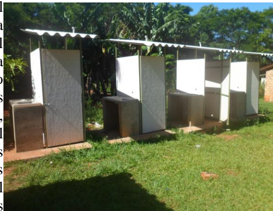
Sanitarios realizados con el CEPRA
