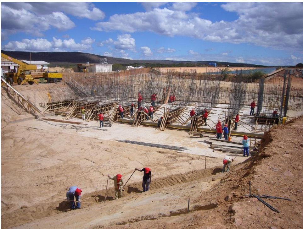
Construção do Canal de Tomada de água do Rio São Francisco
