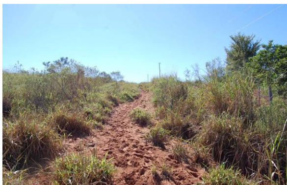
Camino intransitable para vehículos
