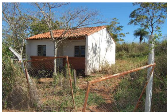
Puesto de salud abandonado
